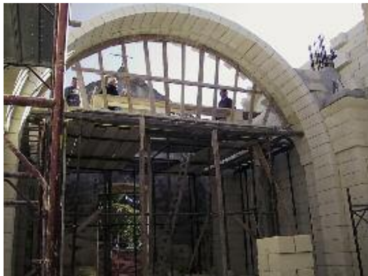
Fasi diverse di costruzione della volta
