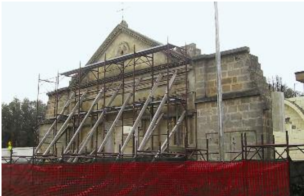
Chiesa crollata facciata est
