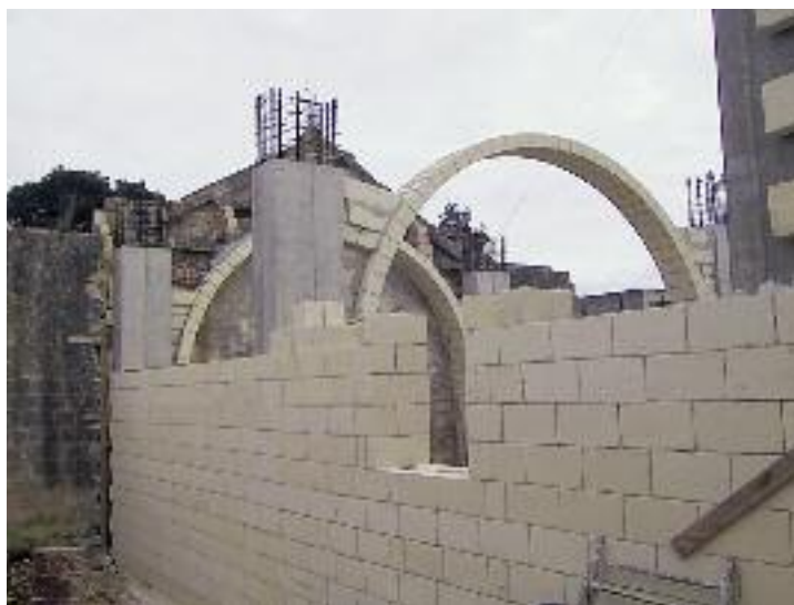
Fasi diverse di costruzione della volta
