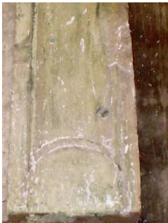
Nicchia salvatasi dal crollo
