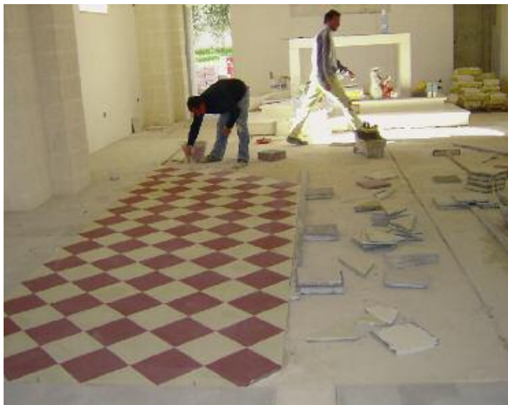
I maestri Mario Turrisi e Pietro Argentieri mentre mettono in opera la nuova pavimentazione della Chiesa
