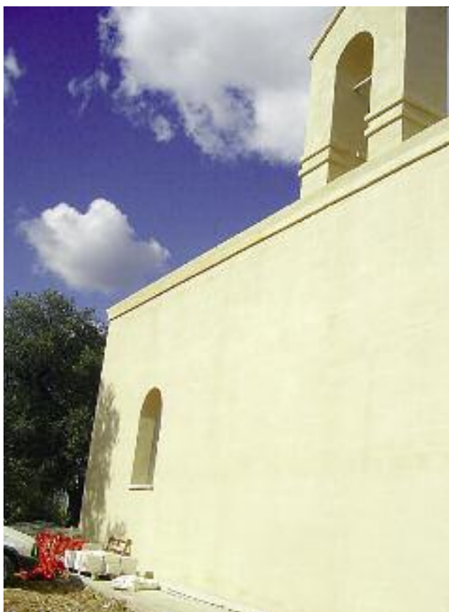
Nuova muratura esterna
