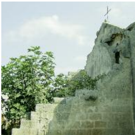
Parte posteriore della facciata est
