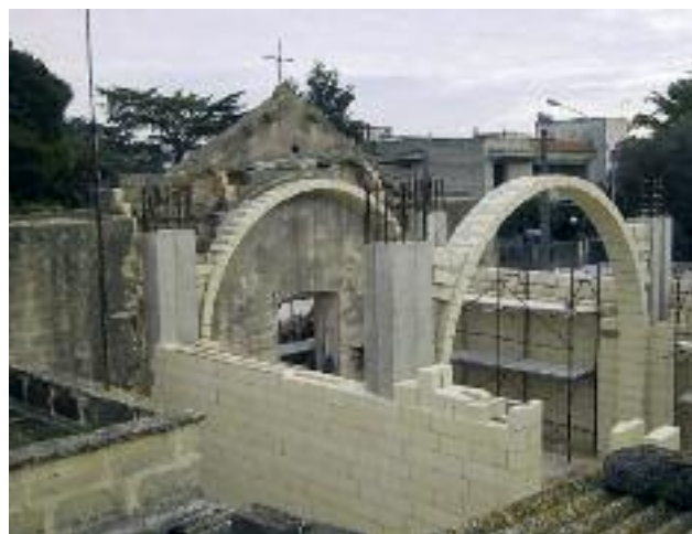
Fasi diverse di costruzione della volta
