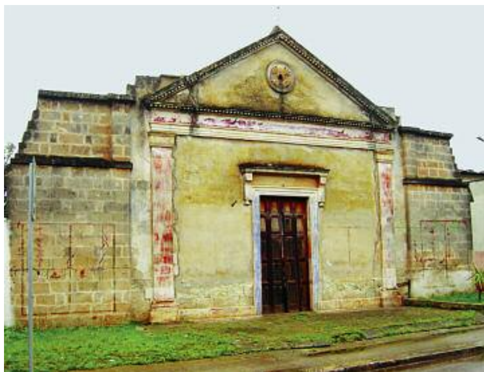
Facciata est prima del restauro
