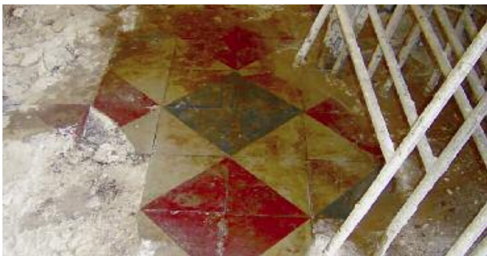
Porzione di pavimento originario rinvenuto dopo i lavori di pulitura delle macerie
