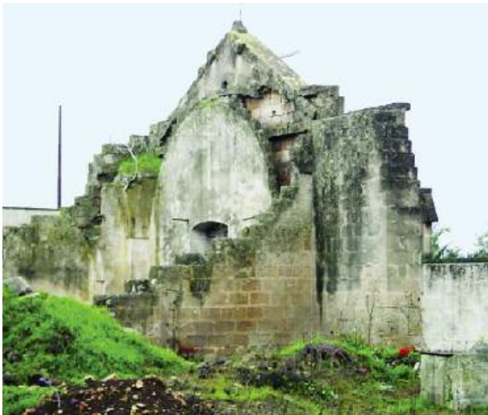
Parte posteriore della facciata est
