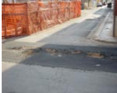
Sede stradale ripristinata e subito resa inagibile per lavori mal eseguiti.
