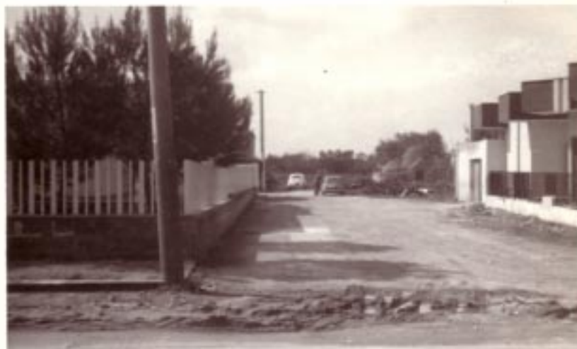
Via Duca D'Aosta incr. via Mattei. Lavori in corso nelle vicinanze del luogo dell'incidente (Foto di repertorio di F. Gorogoni)
